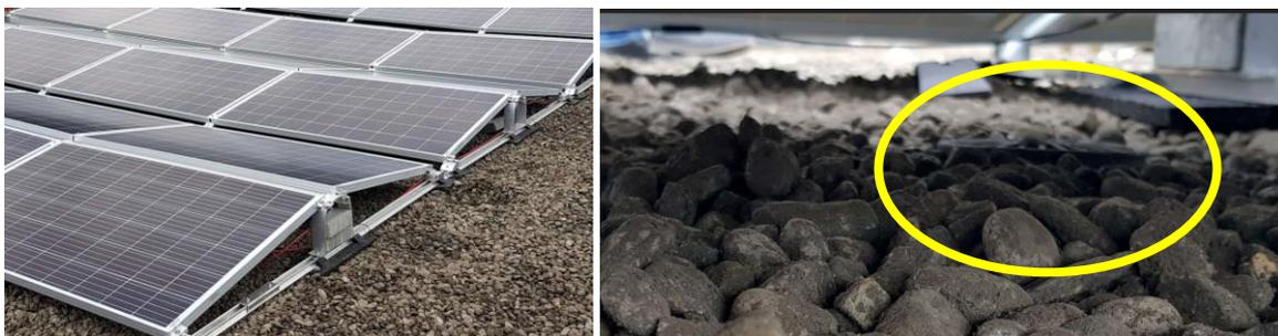
Abbildung 71: Dachentwässerungen verschwinden unter den Paneelen und sind für Kontrolle bzw. Reinigungsarbeiten nicht mehr zugänglich (Quelle: Fa. IBTS GmbH)
