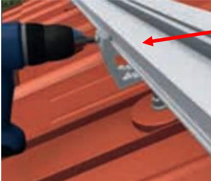
5) Profilschiene setzen und Schraube festziehen (Anzugsmoment: 20Nm)
