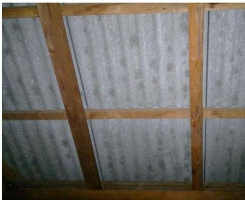
Abbildung 3: Nicht ausgebauter Dachraum ohne Unterdach (Quelle: Fa. IBTS GmbH)
