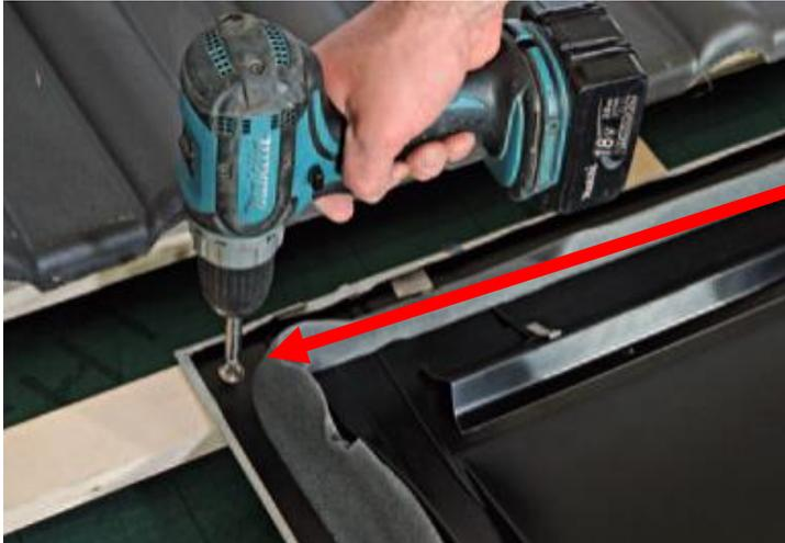
10) Wegen Windsogsicherheit: Ecken und Überlappungen festschrauben → **Modulschrauben** mit **Dichtung** verwenden
