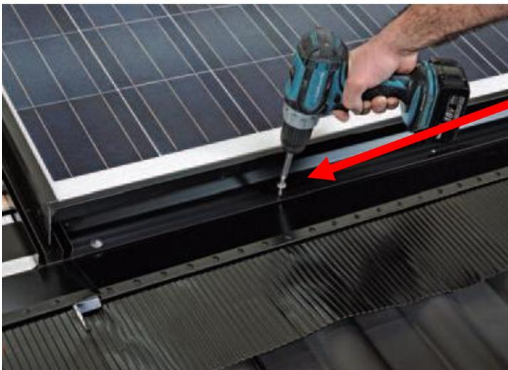
27) untere Module verlegen und mit **Modulschrauben** befestigen
