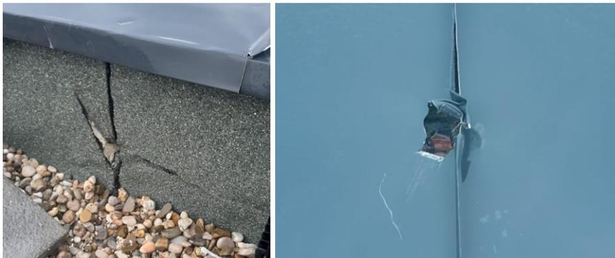
Abbildung 59: Beschädigte Abdichtungen und Blechabdeckungen durch Paneel-Treffer (Quelle: Fa. IBTS GmbH)
