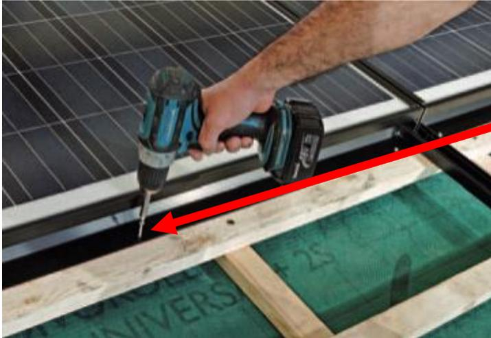
14) Module mit Modulschrauben befestigen
