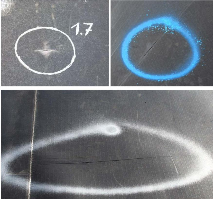
Abbildung 70: Typische Beschädigungen (Schlitze) an Foliendächern durch PV-Befestigungsmaterial (Quelle: Fa. IBTS GmbH)
