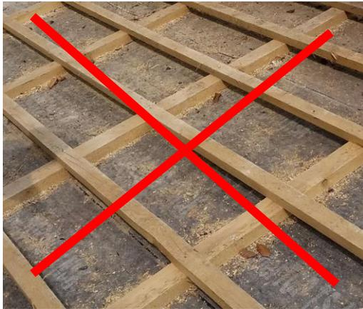
Unterdach (Hinterlüftungsebene) mit Bitumen/Dachpappe vorhanden
