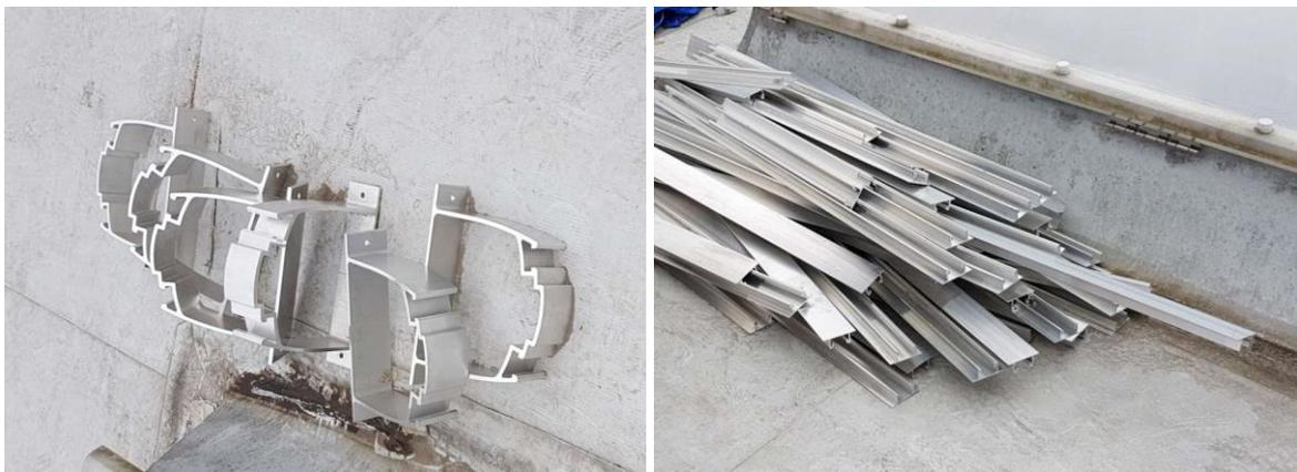
Abbildung 68: Scharfkantige Profile direkt am Dach aufgelegt (Quelle: Fa. IBTS GmbH)
