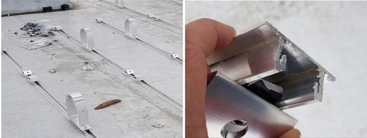
Abbildung 67: Scharfkantige Profile (mit dem Winkelschleifer abgelängt) direkt am Dach aufgelegt (Quelle: Fa. IBTS GmbH)
