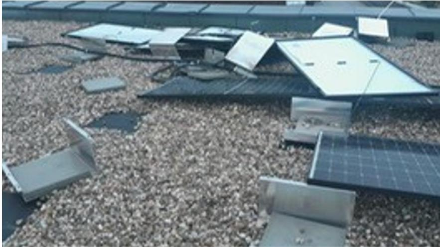
Abbildung 58: Chaos nach Abheben der Module durch zu geringe Beschwerung (Quelle: Fa. IBTS GmbH)
