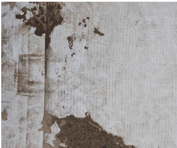
Abbildung 69: Schleifspuren auf der Dachhaut (Quelle: Fa. IBTS GmbH)
