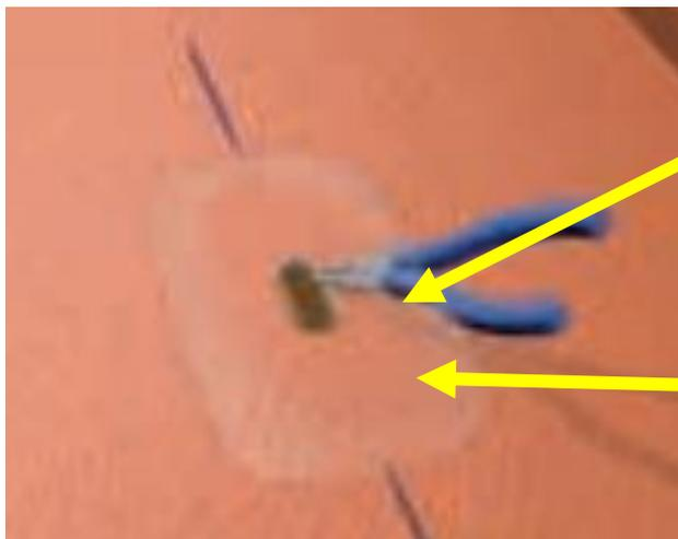
4) Klebestelle an Dacheindeckung und Solarhalter anschleifen
