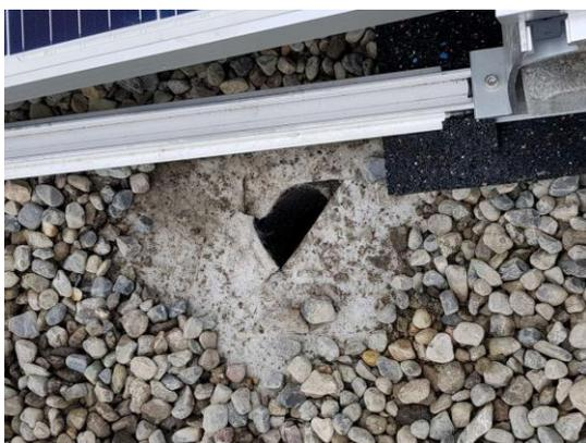
Abbildung 72: Dieser Gully wurde im Zuge der Dachsanierungsarbeiten/Montagearbeiten „verschlossen“. Kontrolle nicht mehr möglich (Quelle: Fa. IBTS GmbH)
