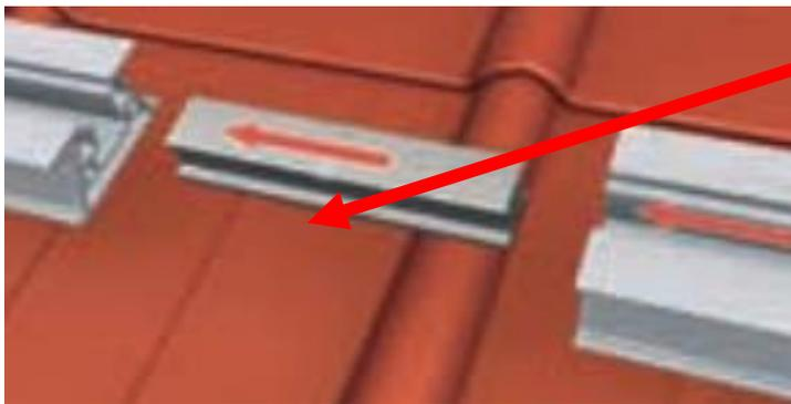
6) Schienenverbinder auf halbe Länge einschieben und weitere Profilschienen zusammenstecken
