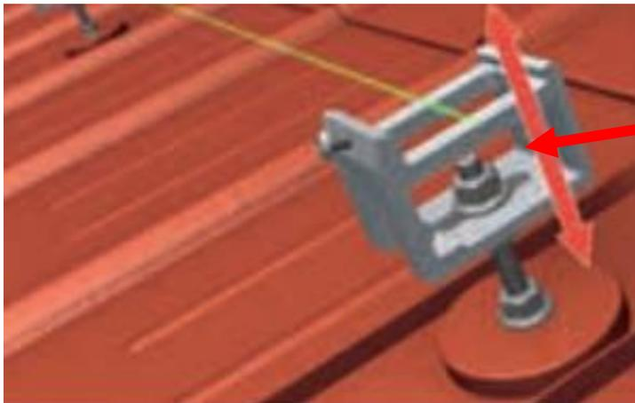
4) Höhe der Solarhalter am Ende einer Reihe oder Spalte einmessen und die restlichen Oberteile mithilfe einer Montagesschnur einrichten
